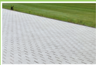
Frankenpflaster- Drain mit 8 mm Fuge
